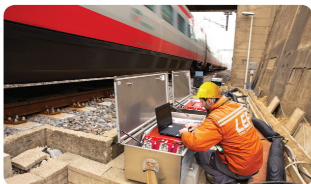
Installazione armadio di piazzale Un tecnico LEF durante l'installazione di un ADP su una linea AV per il riscaldamento elettrico deviatori
